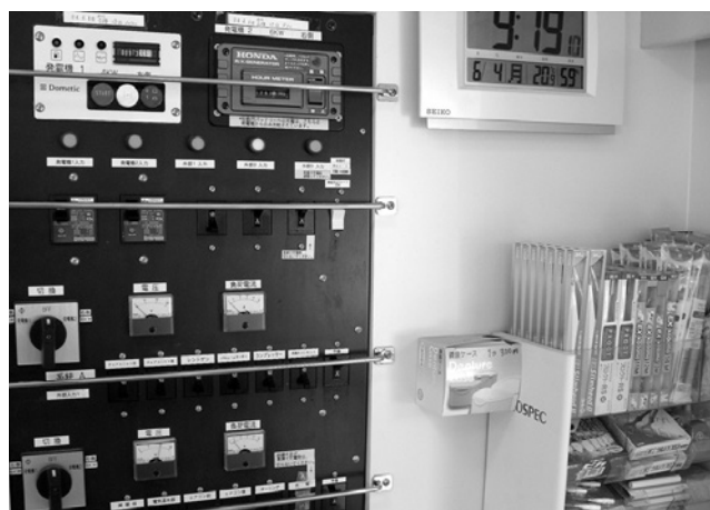
写真5 自家発電機等
