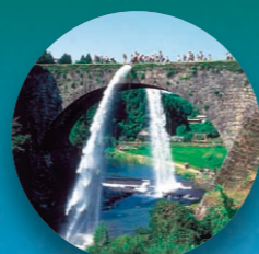
通潤橋(山都町)
